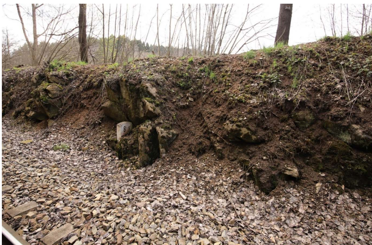
Obrázek 7: Stav míry zvětrání a degradace pravostranného zářezu v km 8,300
