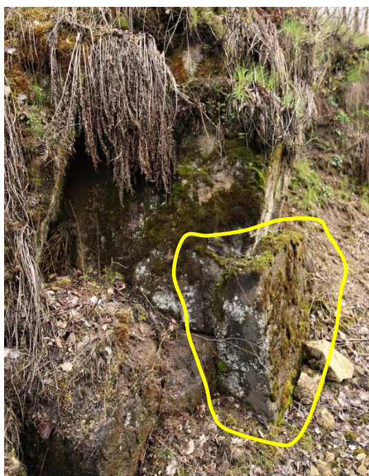
Obrázek 17: Vyznačení staré podbetonávky bloku, která je zcela oddělena od masivu. Vyznačení otevřených puklin s posuny rizikového bloku, velká rychlost otevírání puklin, blok oddělen na více jak 45 mm od masivu
