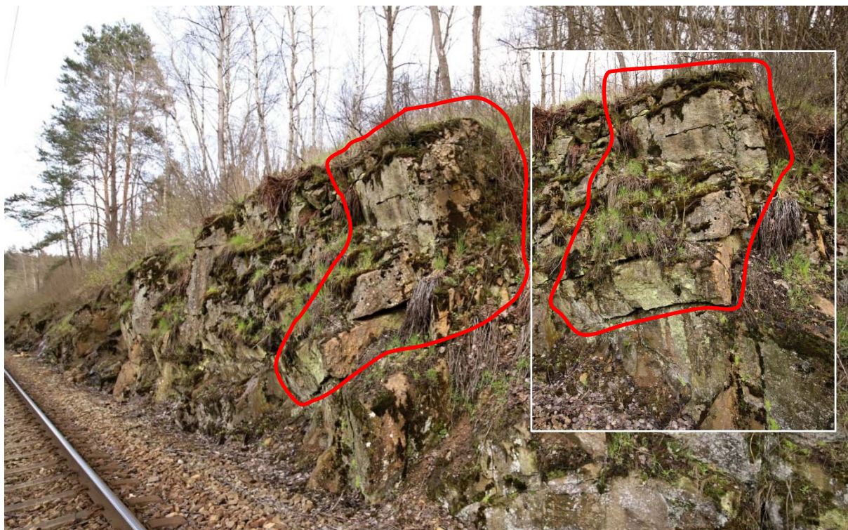
Obrázek 18: Povaha a stav rizikového bloku v km 8,335 s nutností odtěžení s stabilizace okolí bloku sítěmi
