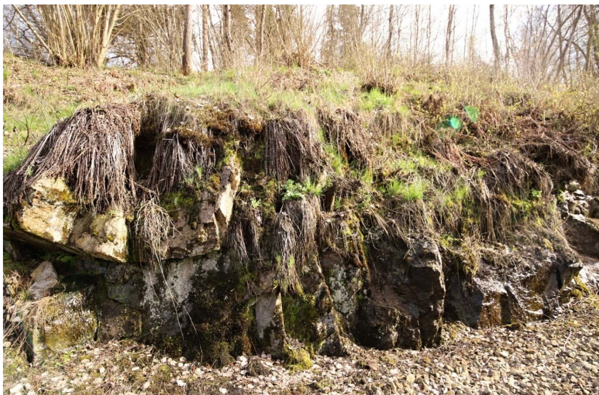
Obrázek 8: Stavba levostranného zářezu v km 8,245 s patrnými výraznými výrony vody z puklin
