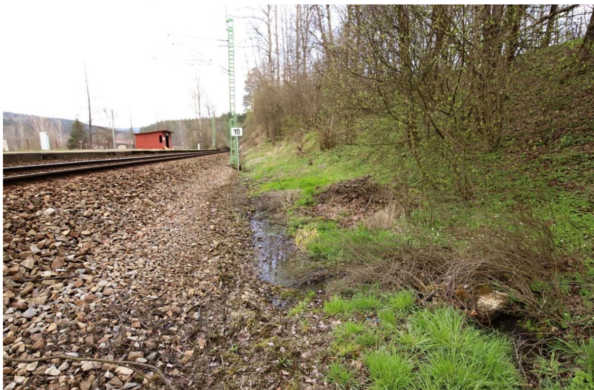
Obrázek 6: Stav zaplnění podélného odvodnění na levé straně v km 8,400 - 8,480, stojící laguna vody
