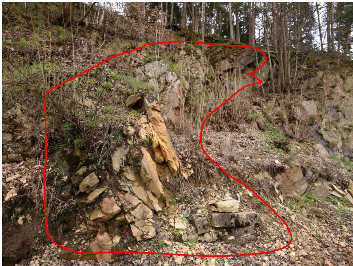
Obrázek 28: detail stavu degradace masivu v km 11,284 se zbytky původní kamenné zídky, vyznačené blokové struktury nutné k odtěžení, vysoce rizikové
