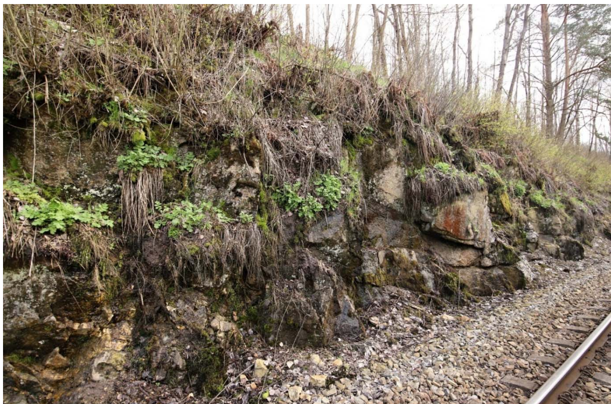
Obrázek 12: Stav zářezu s blokovými rizikovými strukturami v km 8,300 - 8,320
