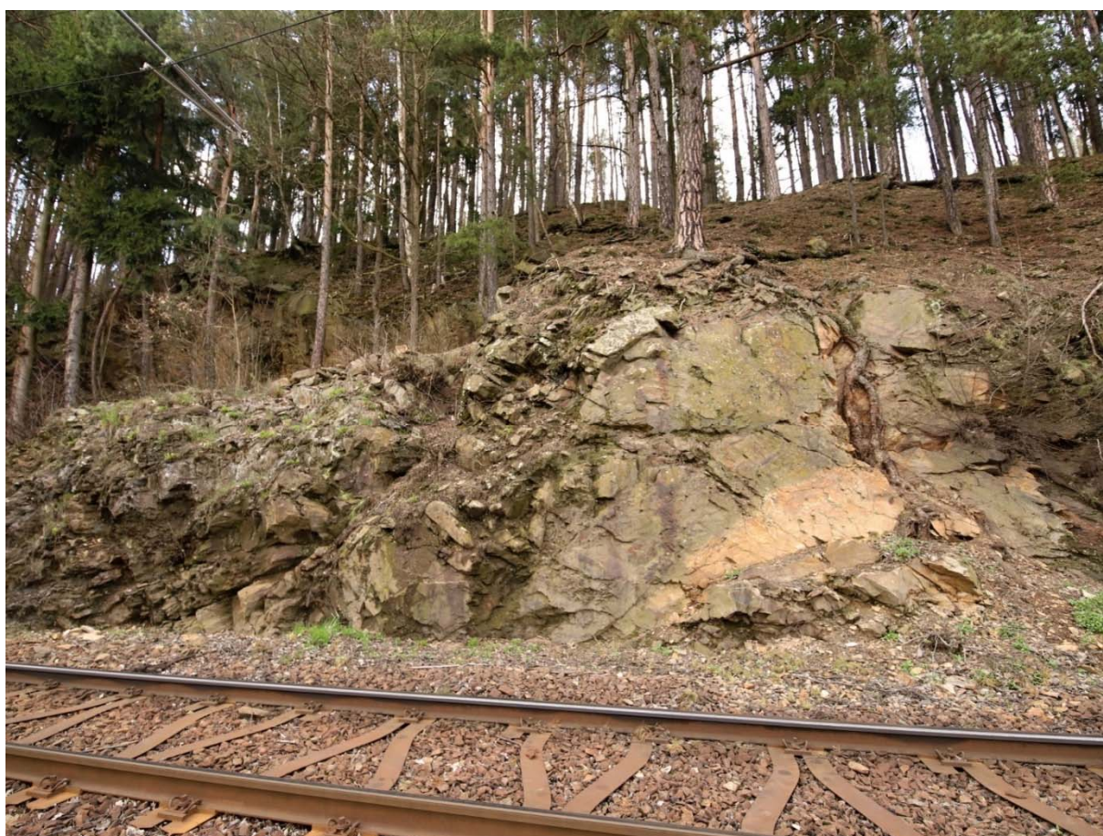
Obrázek 35: stav masivu narušeném předchozím řízením působením kořenového systému stromu na hraně masivu v km 11,336 vpravo
