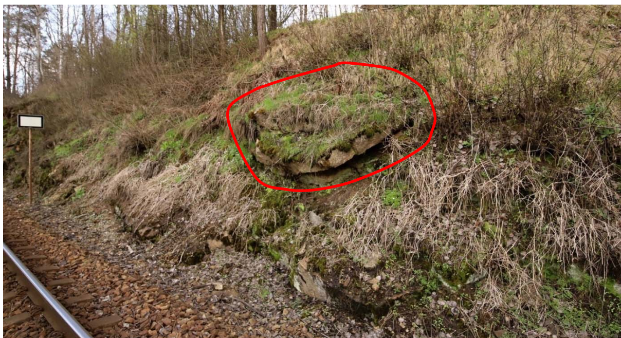
Obrázek 19: Solitérní, zcela oddělený blok v pohybu - pomalé sunutí ze svahu v km 8,360 vlevo
