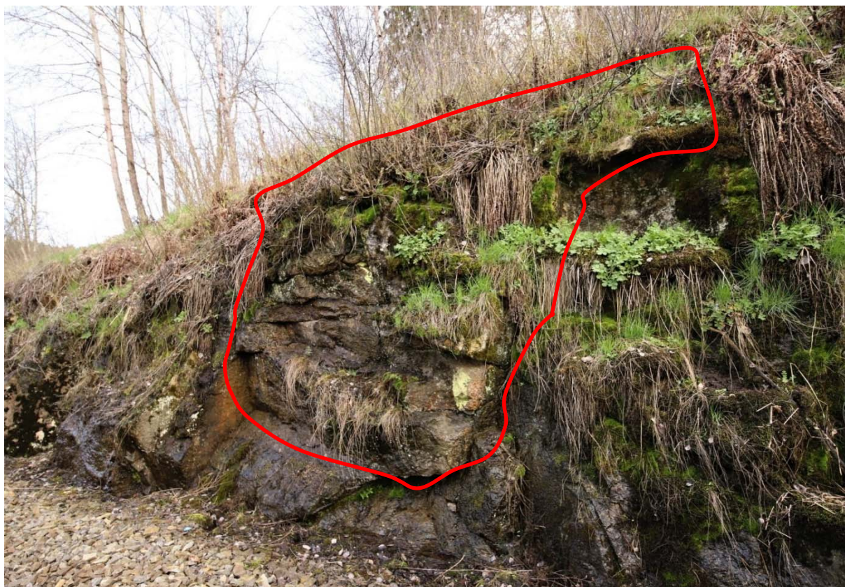
Obrázek 10: stav narušení masivu a uvolněné blokové struktury, které je nutné odtěžit, km 8,263 - 8,268
