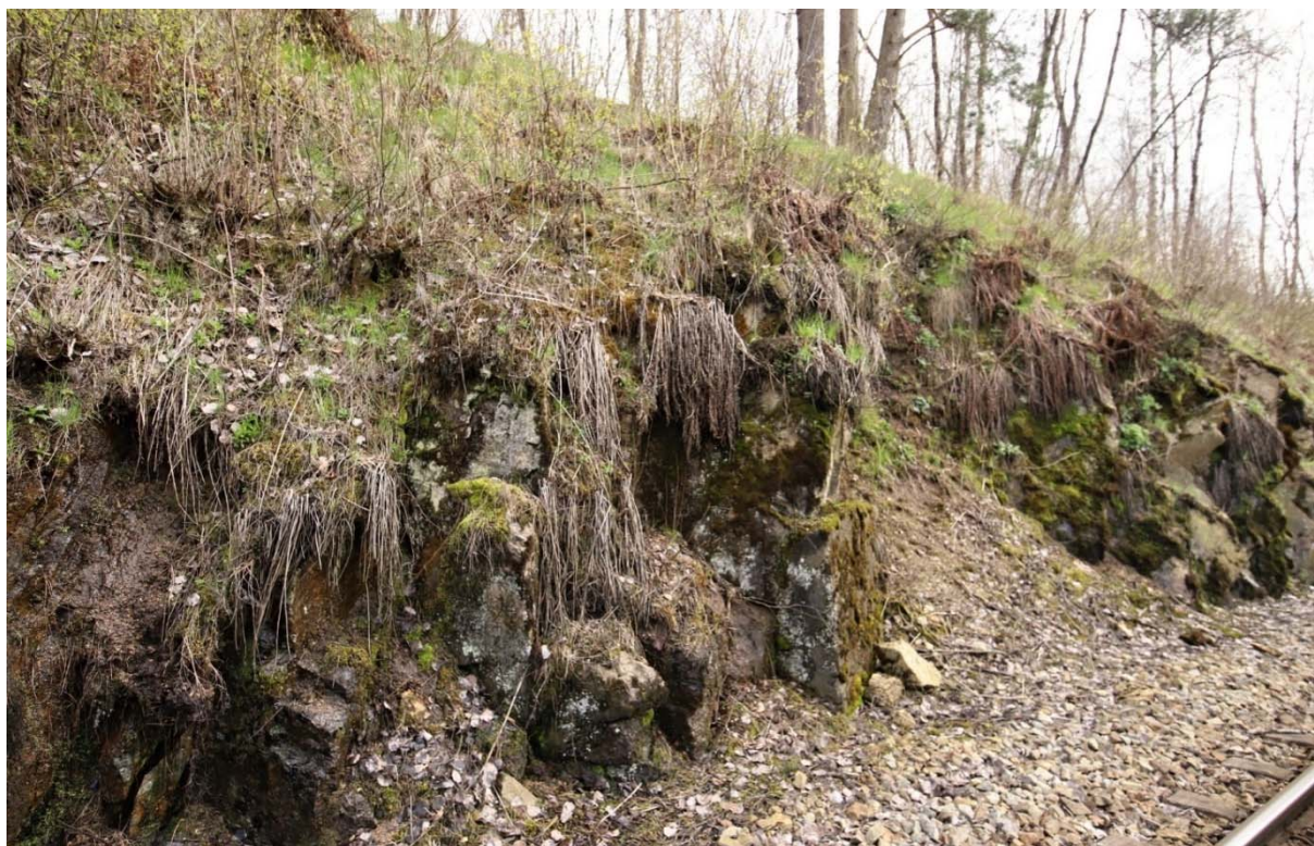
Obrázek 9: uspořádání levostranné části v km 8,255 - 8,260 s osypovými kužely až ke kolejovému loži
