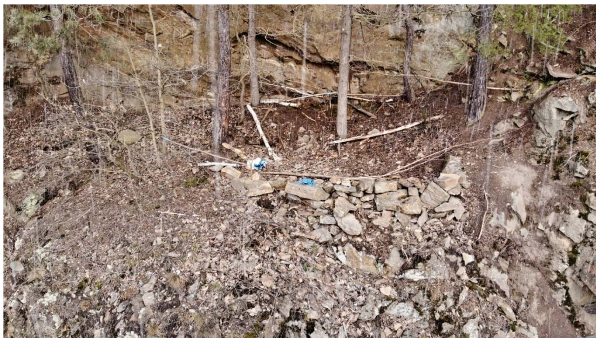
Obrázek 37: kamenná rovinanina na hraně svahu přímo ohrožující provoz na trati, bude odstraněna
