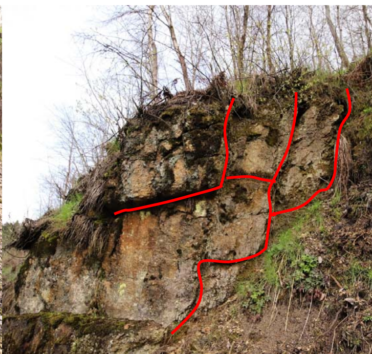
Obrázek 17: Vyznačení staré podbetonávky bloku, která je zcela oddělena od masivu. Vyznačení otevřených puklin s posuny rizikového bloku, velká rychlost otevírání puklin, blok oddělen na více jak 45 mm od masivu
