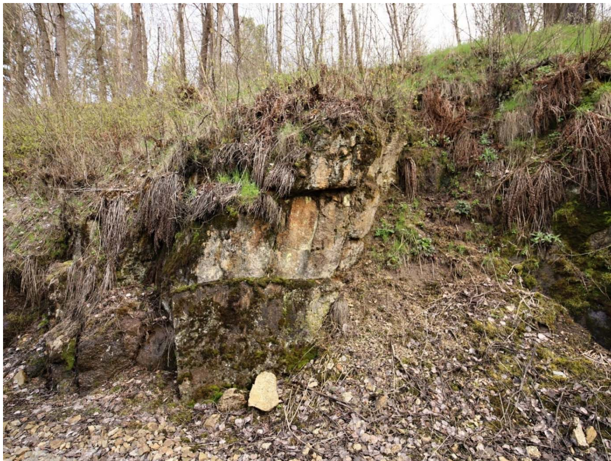
Obrázek 16: Rizikový blok v km 8,288 se spodní podbetonávkou, místo opakovaných udílostí řícení
