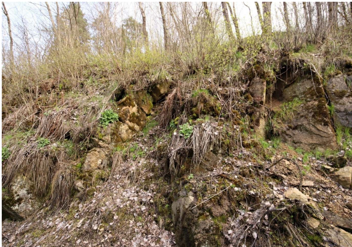
Obrázek 14: Zcela rozložené a rozpadlé bloky masivu v km 8,300 horní partie
