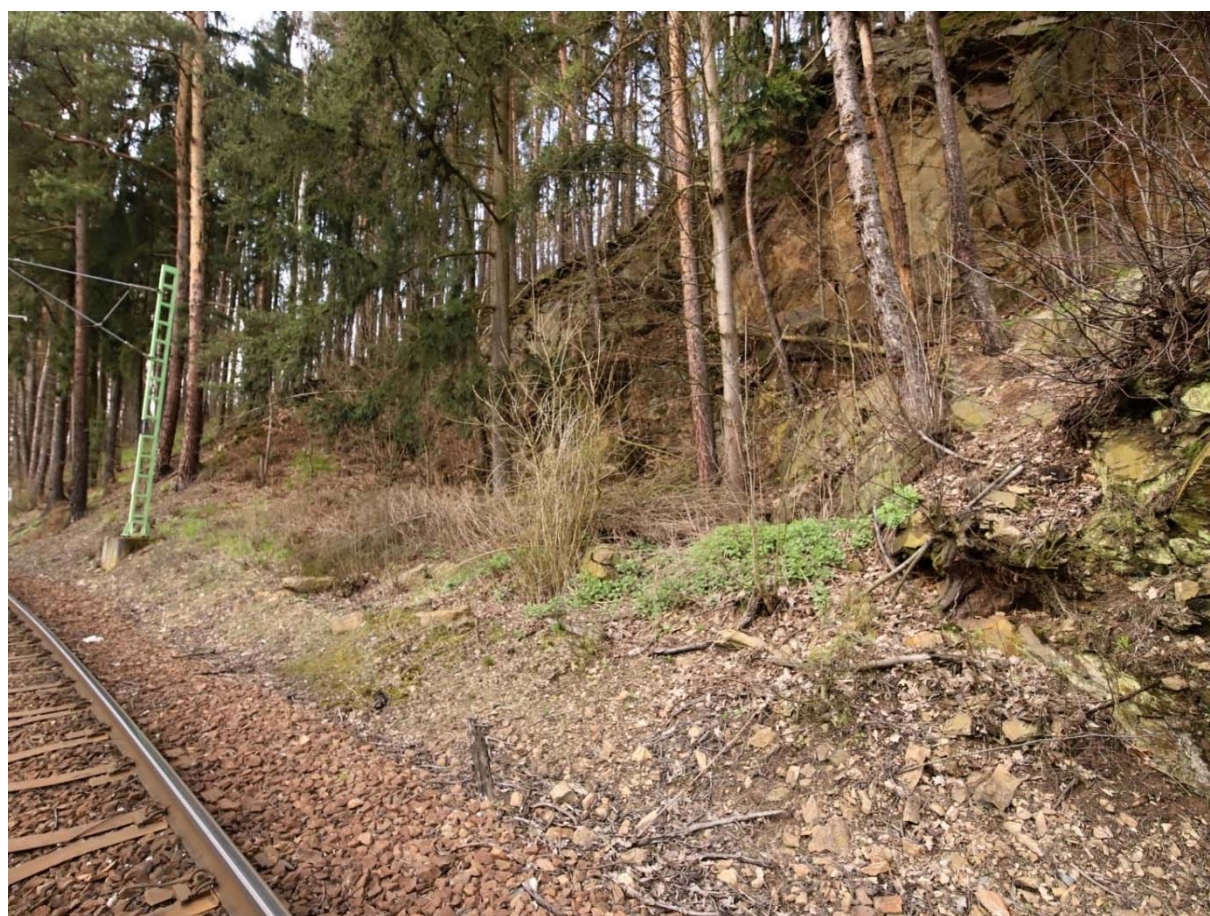
Obrázek 39: prostor pro uložení rubaniny v km 11,345 - 11,363, přístup z koleje, prostor bude nutné částečně upravit a srovnat pro uložení rubaniny, dílčí kácení stromů a náletu v prostoru lomu, úsek končící sloupem trakce č. 289
