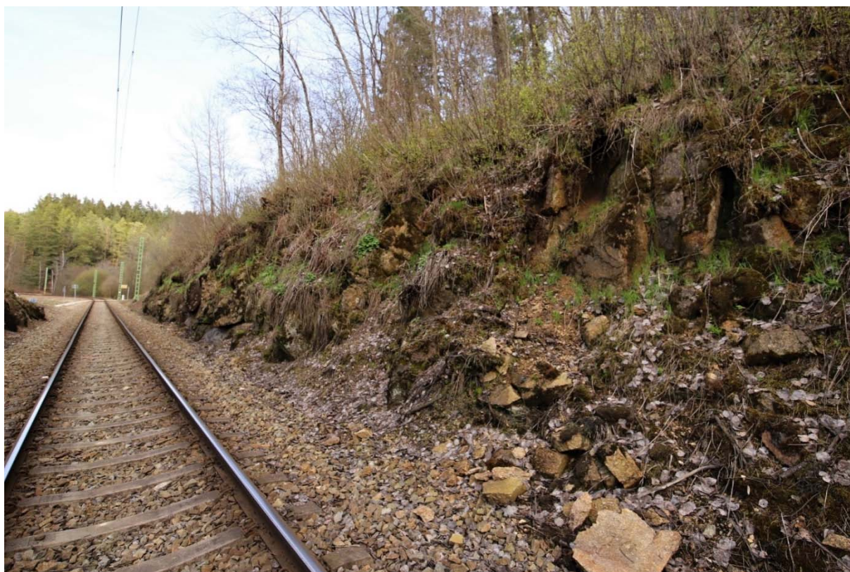
Obrázek 15: Rozpad bloků v levostranné části zářezu v km 8,300, opad zasahuje kolejový svršek, akumulační prostor je zaplněn, nepřijatelné riziko pro bezpečnost provozu
